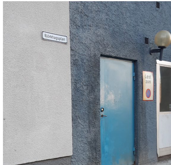
Befintlig gatuskylt på fasad mot öst.
