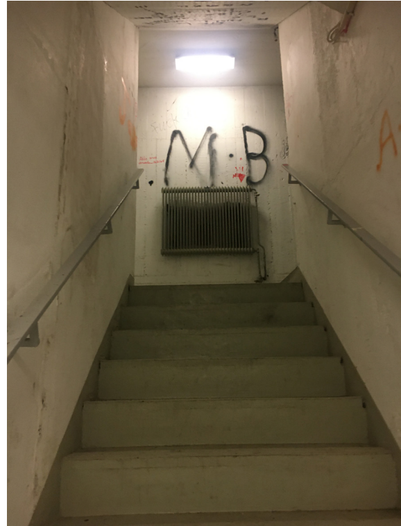
Brandtrappan upp/ned från källaren.
